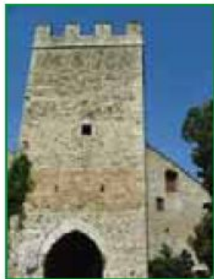
La porta sud del castello di Calenzano
